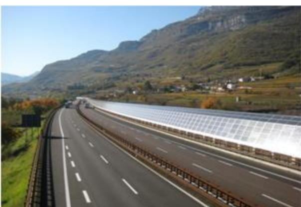
impianto su autostrada (barriera acustica)
