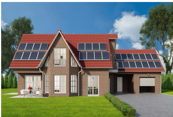
impianto a servizio di abitazione
