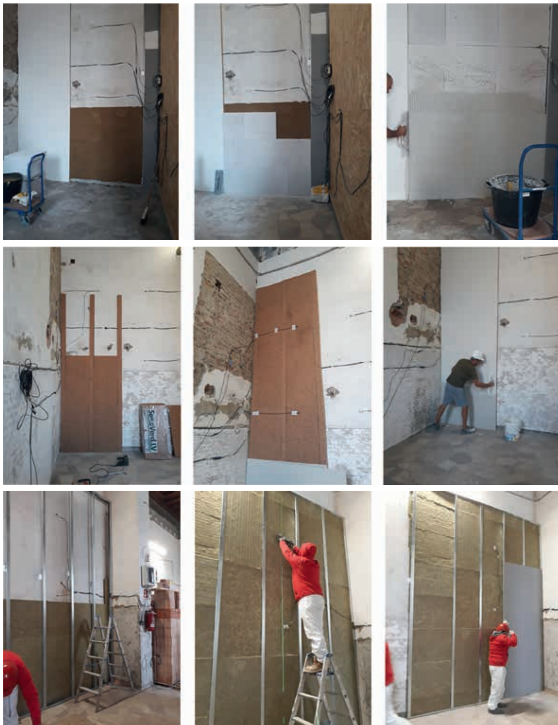
Figura 2 – Fasi dell'installazione delle tre tecnologie di isolamento termico scelte per i test: blocchi in isolante minerale incollati con malta reversibile (a); pannelli in sughero montati a secco con struttura in legno (b); pannelli di lana di roccia con montanti in acciaio separati dal muro con uno dei due pannelli isolanti (c)
