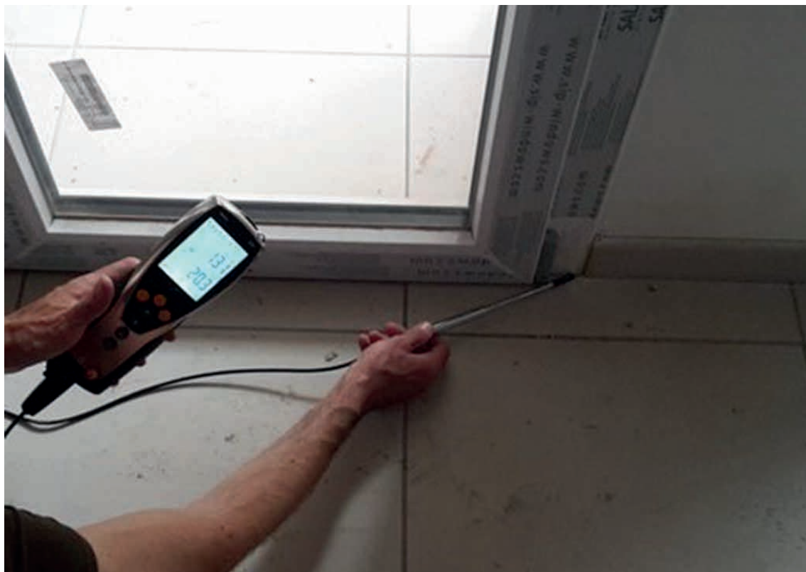
Figura 5 – Indagine con sonda anemometrica a filo caldo svolta durante Blower Door Test. La prova permette di verificare la velocità del flusso d'aria e dunque l'entità delle infiltrazioni d'aria. Foto degli autori
