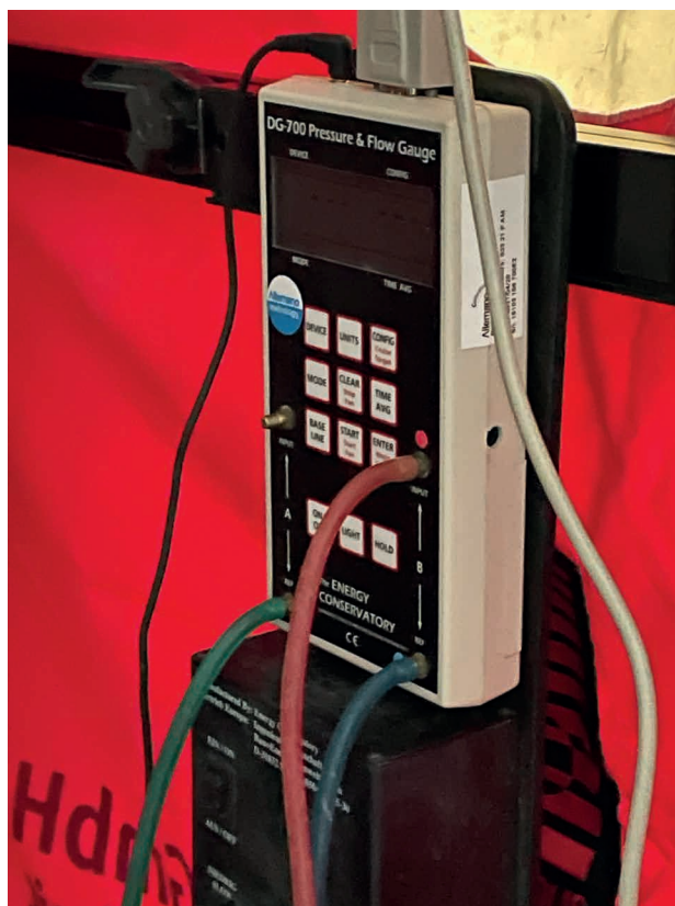
Figura 3 – Preparazione della strumentazione per l'avvio del Blower Door Test. In particolare, l'immagine è riferita al manometro, strumento utile per la misurazione e il controllo della pressione interna al/ai locale/i di cui si vuole valutare l'ermeticità. Foto degli autori
