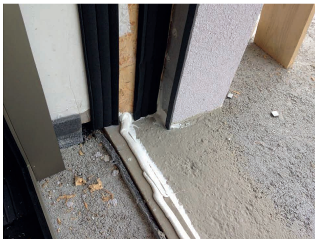
Figura 2 – Preparazione della bucatura per la posa in opera dell'infisso mediante sigillatura dei giunti con nastri multifunzione e MS polimero. Foto di SistemaBisacchi, via Licenze Creative Commons (disponibile al sito: https://www.blogbisacchi.it/montaggio-infissi/ )
