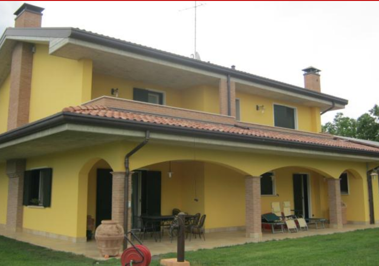
Edificio in Muratura Portante rettificata
