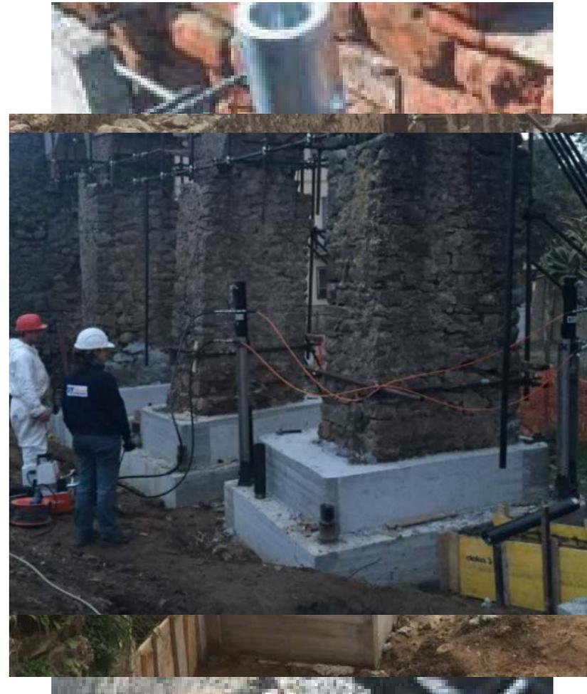
Nel caso il fabbricato non abbia fondazioni in c.a. ma bensì in muratura di buona qualità è possibile usare un piastraggio - cordonatura continua in acciaio.
