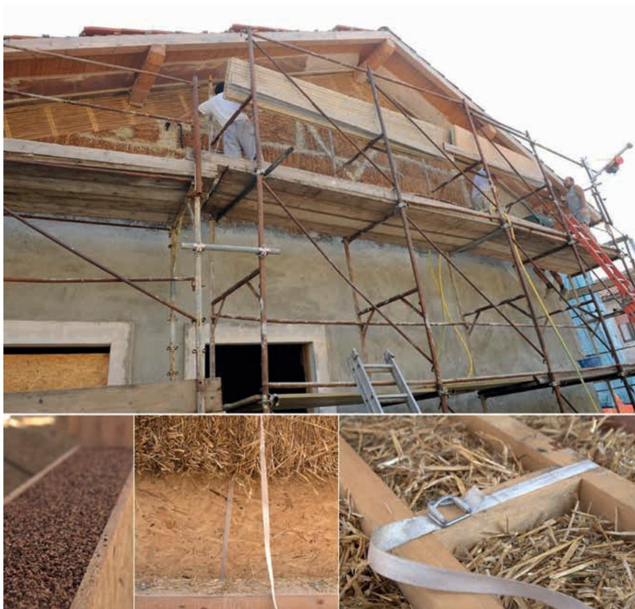
Fig. 12 – Applicazione di stuoie di canne palustri per uniformare i punti di discontinuità materica (immagine in alto) e soluzione tecnica con sughero (immagine in basso) per la protezione contro l'umidità di risalita delle balle di paglia che in corrispondenza dell'attacco a terra, vengono rialzate (© arch. M. Macri e arch. S. Mancuso)
