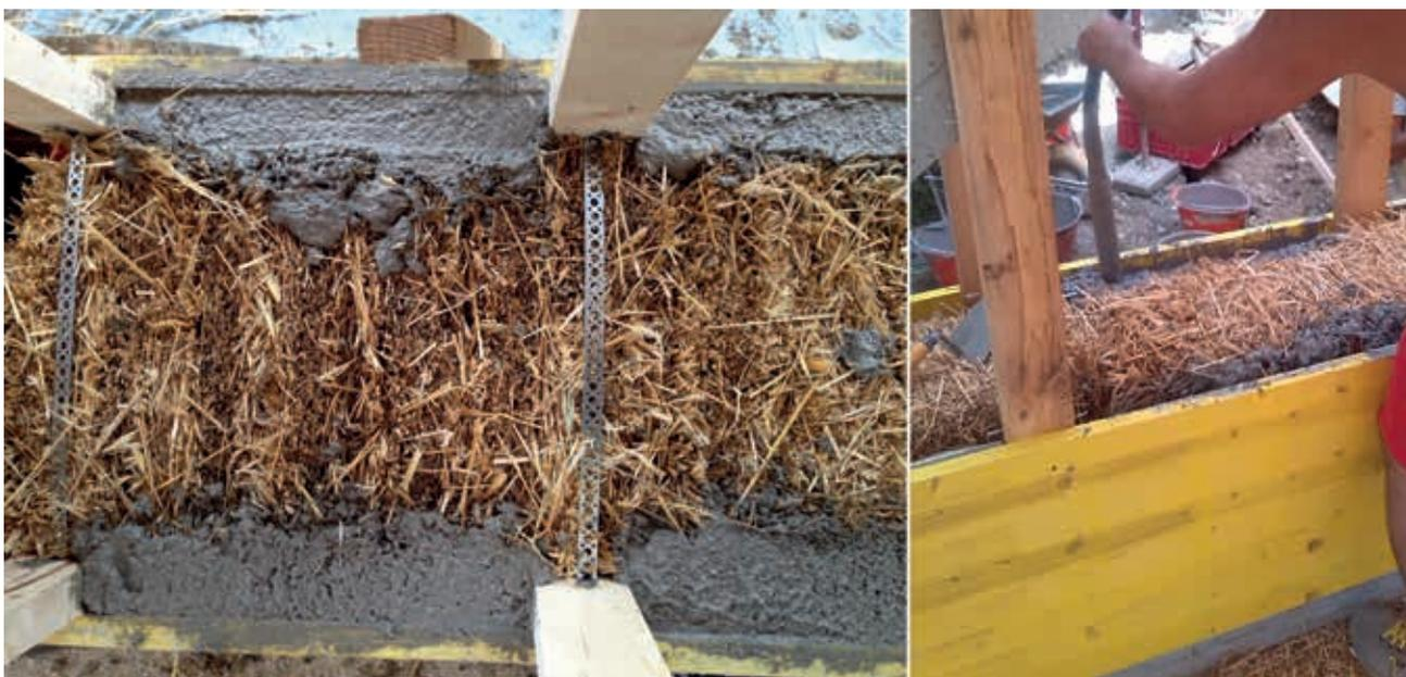
Fig. 7 – Composizione della muratura GREB. La stratificazione finale è formata in questo caso (immagine a sinistra) da malta GREB, balla di paglia e ancora malta GREB. Seguirà l'applicazione dell'intonaco. Di corso in corso la struttura dei montanti lignei è collegata con fascette metalliche. A destra, applicazione del getto di malta, dopo la predisposizione delle casserature (© ing. G. Nardini e arch. M. Ricci)
