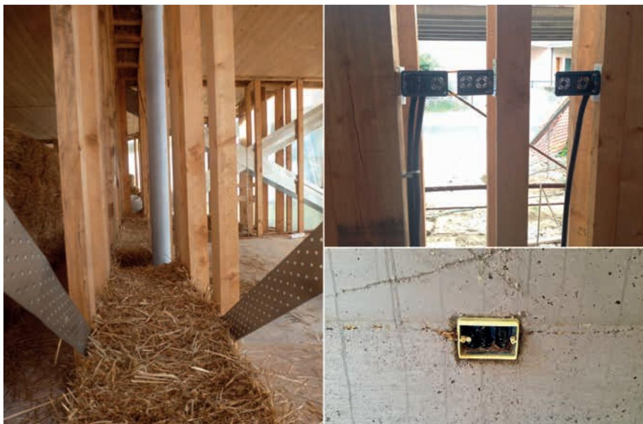
Fig. 8 – Dettagli dell'integrazione impiantistica. Inserimento di canalizzazioni di media dimensione (immagine a sinistra). Applicazione dei componenti dell'impianto elettrico sulla struttura lignea (in alto a destra). Scatola dell'impianto elettrico prima dell'applicazione finale dell'intonaco e della tinteggiatura (in basso a destra) (© Ing. G. Nardini e arch. M. Ricci)
