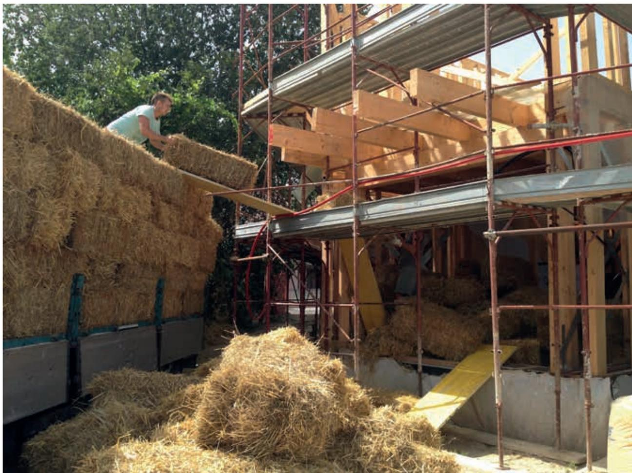
Fig. 4 – Fornitura dei “blocchi” di paglia per il tamponamento delle pareti (© ing. G. Nardini e arch. M. Ricci)
