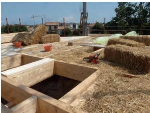
Fig. 6 – Il solaio è composto dalla griglia di travi in legno lamellare, con chiusura inferiore in tavole di legno e con tamponamento in balle di paglia. La lavorabilità della paglia risulta piuttosto agevole poiché richiede solo uno strumento di taglio per sagomarla, in ragione degli spazi lasciati dalla struttura (© ing. G. Nardini e arch. M. Ricci)
