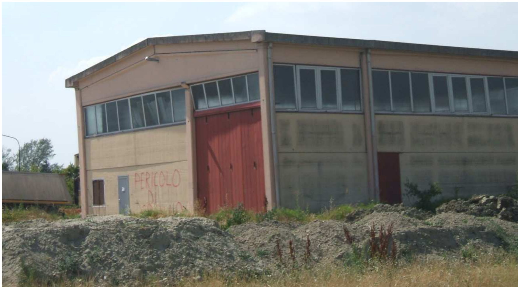
Rotazione rigida della trave di copertura per eccentricità della copertura (foto Autore Ferrara 2012)
