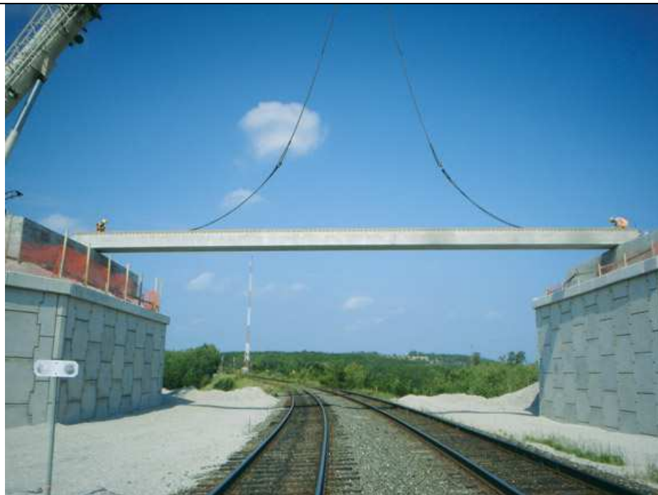
Varo di una trave di impalcato (UK)
